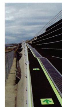
川内町に設置された緊急一時避難場所
